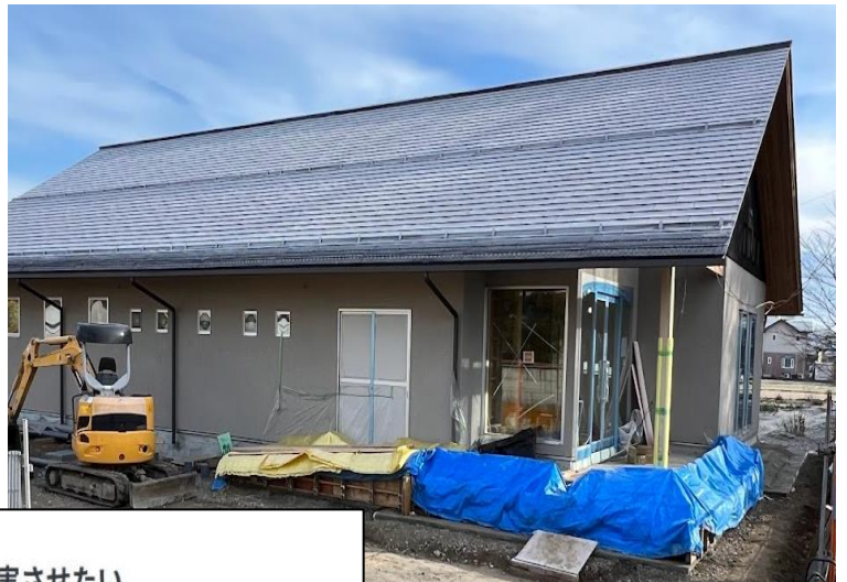
(作業が進む玄関前)
